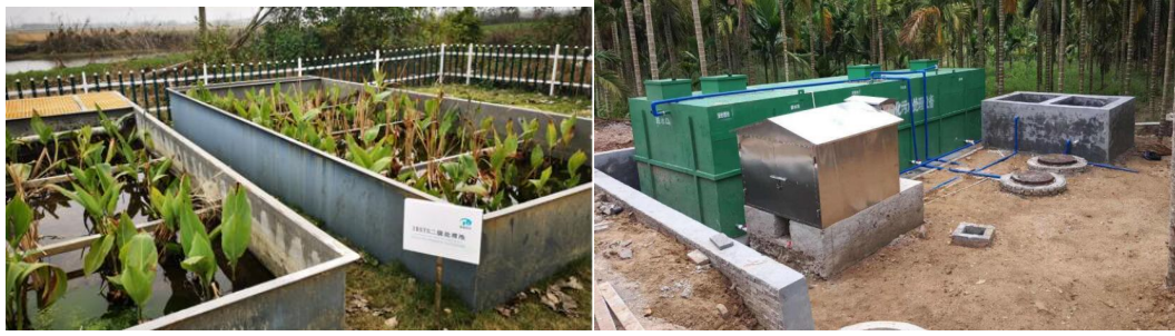
图 2 智能生活污水一体化处理设备应用现场
